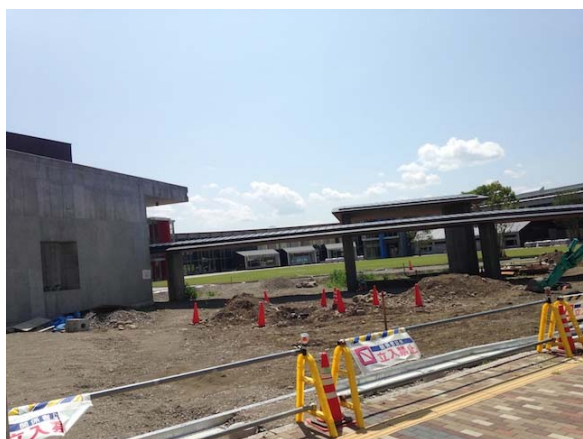
外構等は工事中
