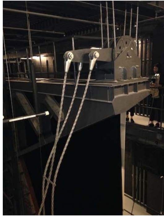
後部吊上げ格納自動変角式音響反射板
