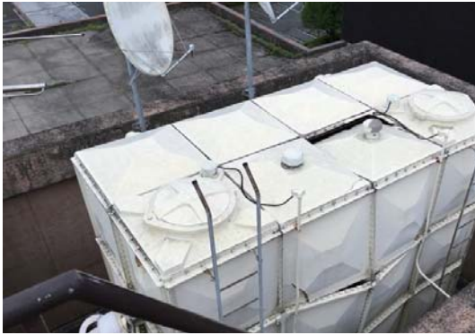
タンクの破損
