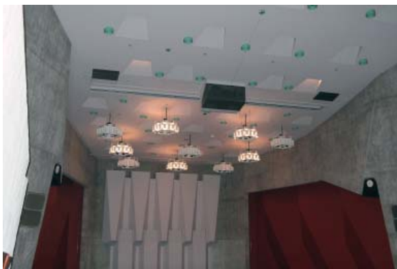
スピーカの揺れにより天井剥離
