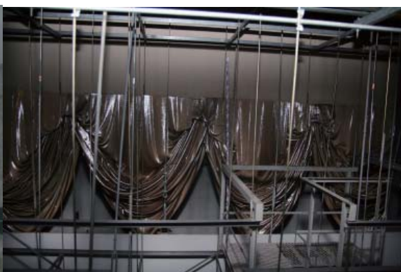
剥離落下した天井ボード
