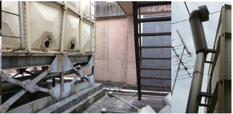
パイプの破損
