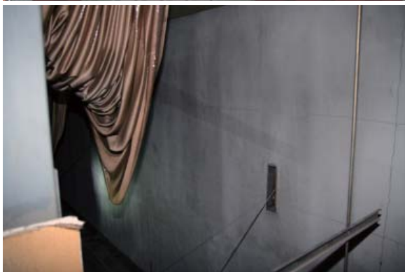
絞り緞帳裏 隔壁一面に亀裂
