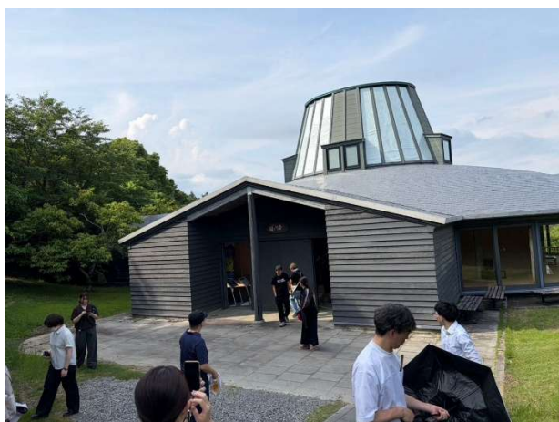
屋内ホール「楢円堂」_外観
